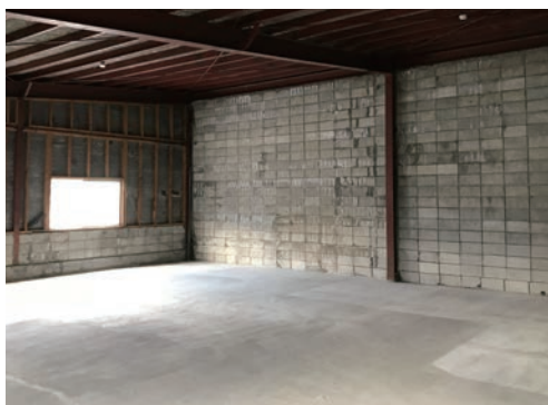
3階建ての空き店舗「角十」からは およそ25㎡以上の荷物を搬出。
